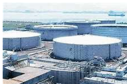
石油貯蔵タンク
